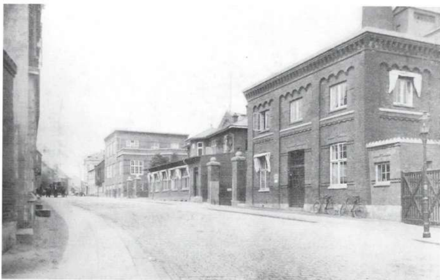
Administrationsbygningen, der lå ud mod Jægergårdsgade, blev bygget i 1903. Arkitekten var R. Frimodt Clausen.
