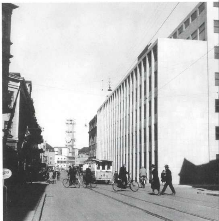
Da den nye administrationsbygning stod færdig, havde Århus fået endnu et markant bygningsværk. (Foto i Lokalhistorisk Samling)
